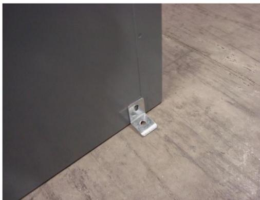
Insérer la grande équerre dans la perforation au bas de l'armoire. Percer le sol, mettre l'ancrage et visser.
