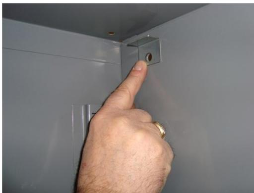
Insérer la petite équerre métallique à l'intérieur de l'armoire. Percer le mur et mettre l'ancrage en mettant une rondelle devant l'équerre.
